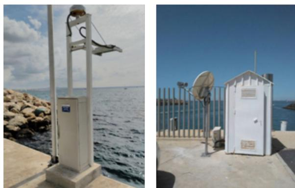
Fig. 5. Estaciones de la red REDMAR de Puertos del Estado, una de las componentes fundamentales de la red marina en la costa española. Abajo: estación de Palma con sensor GNSS (izqda.) y estación de Huelva con instalación de VSAT (dcha.).
