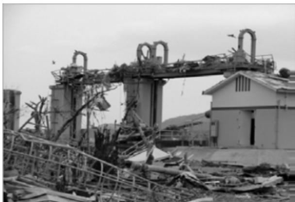
Fig. 4. Estado de las compuertas anti-tsunami en Mina-mi-Sanriku, de 8 metros de altura, a donde llegaron olas de 12 metros.
