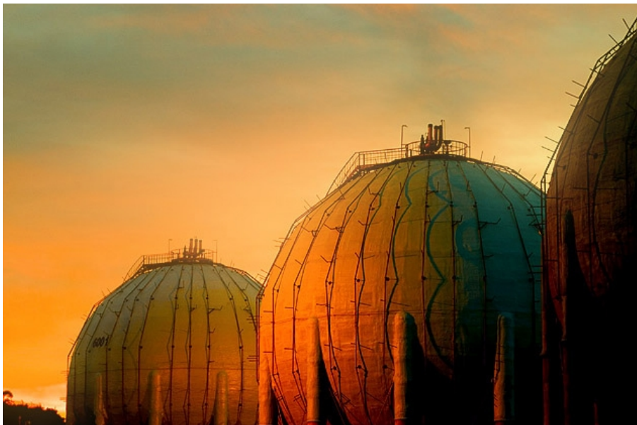
Imagen 2. Esferas de gases licuados del petróleo (GLP).
